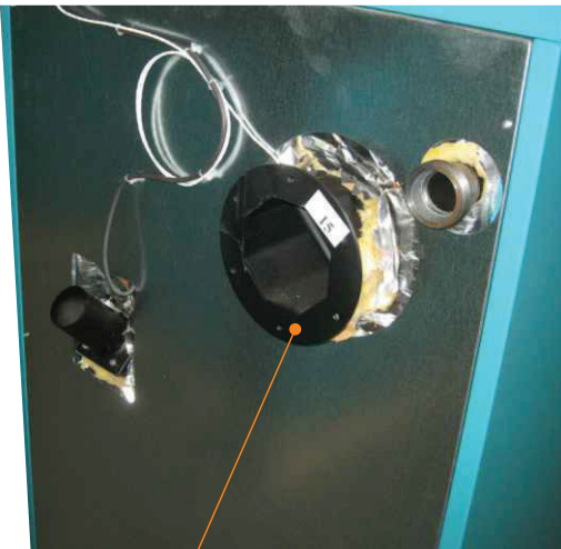
Atloks ventilatora montāžai
