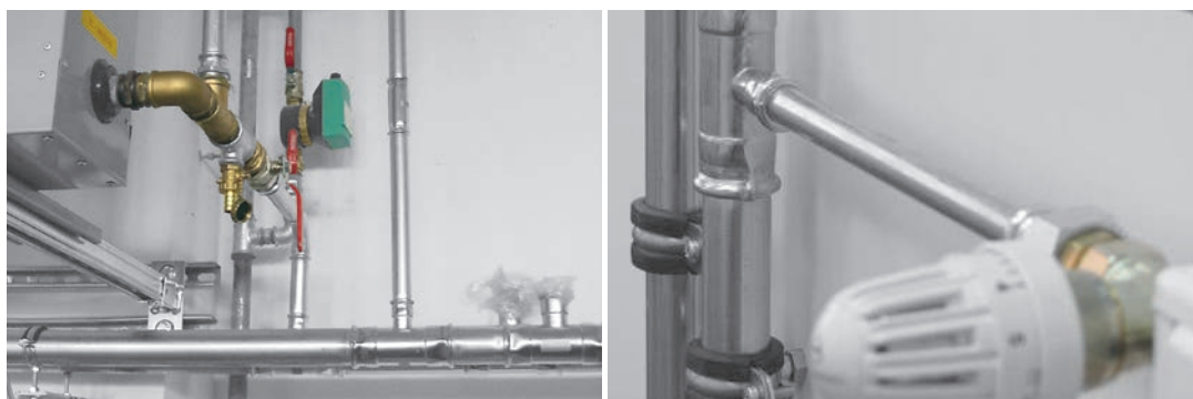
Att. of KAN-therm Steel sistēmas instalāciju piemēri
