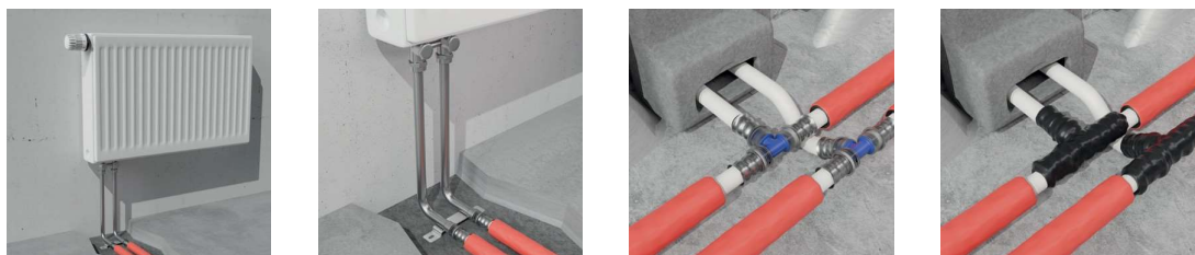
49.att.: Radiatora uzstādīšanas piemēri, izmantojot leņķveida savienotājcaurules.
