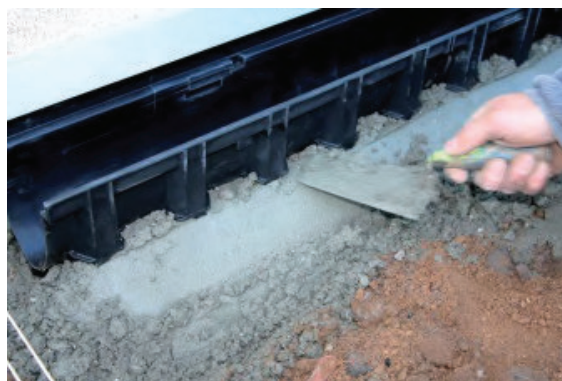
Teknes jāklāj uz betona pamatnes
