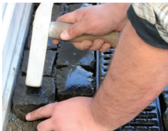
Montāža bruģa segumā
