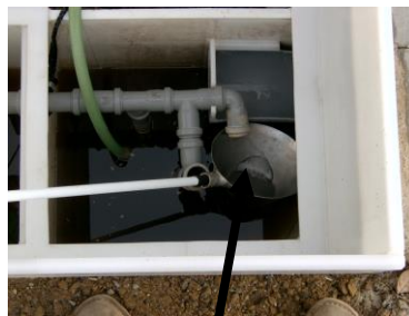
Paraugu ņemšana pagriežot aerolifta caurules līkumu
