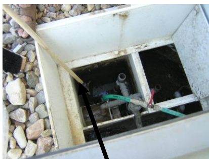
Uzpeldējušo nogulšņu nosmelšana no otrreizējā nostādinātāja
