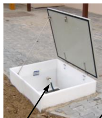
Atbalsta stieņa nostiprināšana pie atvērta vāka
