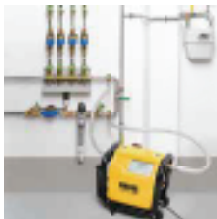
Dzeramā ūdens sistēmu skalošana
